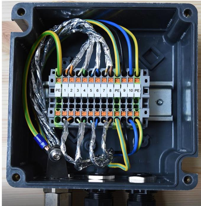
Bild 5-5 Foto des belegten Klemmkastens ExTB-3
